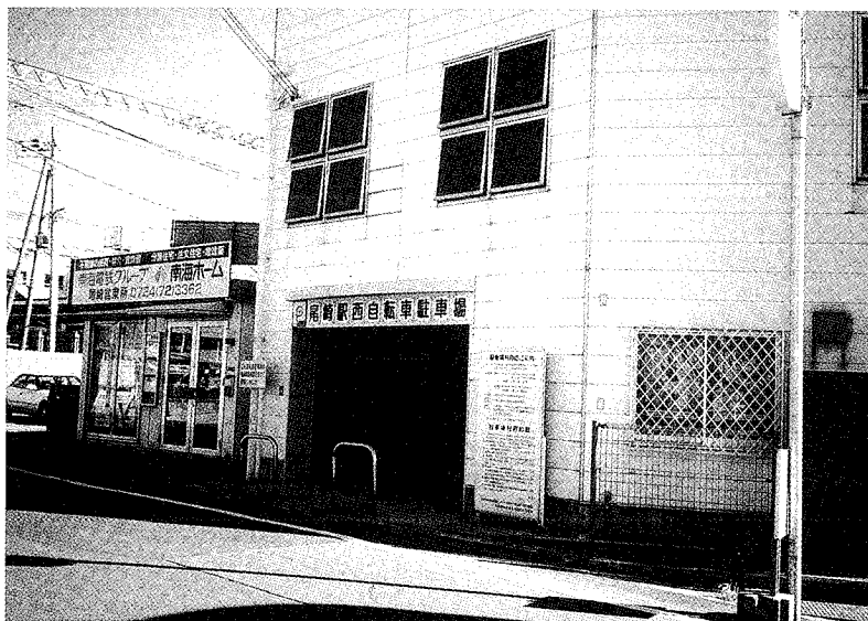
尾崎駅西自転車駐輪場
