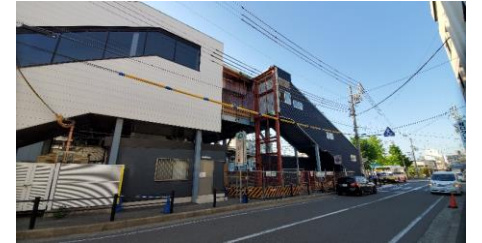
尾崎駅山側のエレベーター工事
