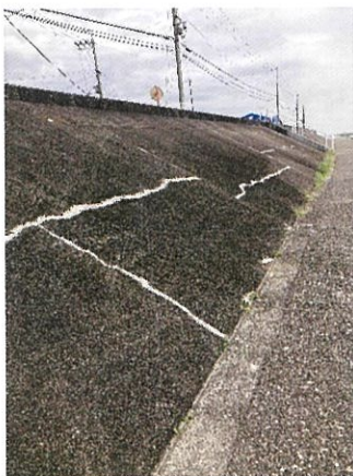
男里川法面補修
