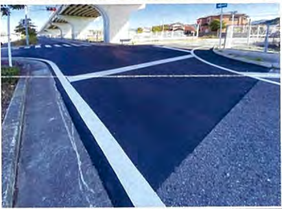
修繕された「高架下の道路」
