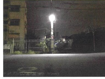
LED防犯灯の新設
