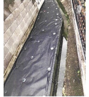
防草シートの新設
