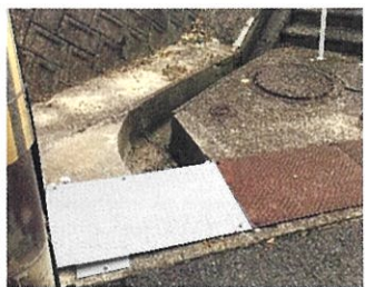
側溝ふたの新設
