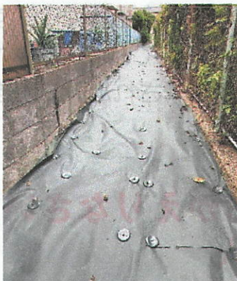
防草シートの設置【黒田】
