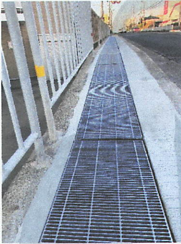
グレーチングの新設【鳥取】
