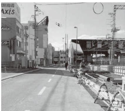
▲尾崎石田線道路の様子
