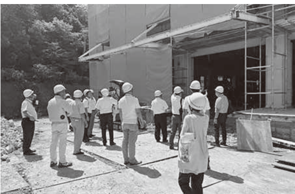
▲工事中の学校給食センターでの視察の様子
