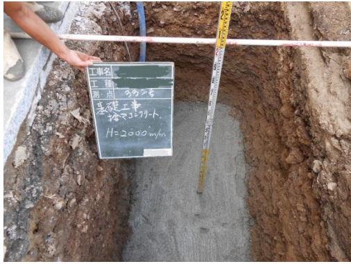
NO.4 基礎工事 (50mm 以上) 【捨てコンクリート工事】
