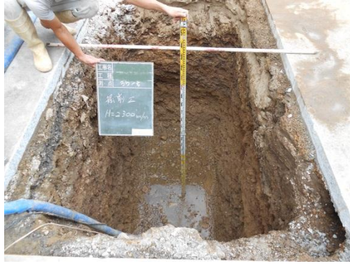
NO.2 掘削工事 【根切り工事】
