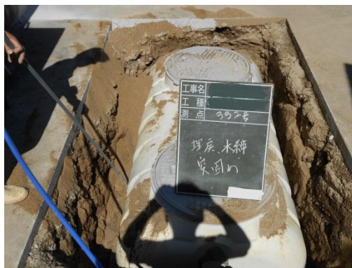
NO.11 埋戻し工事 【下半分 突き固め】
