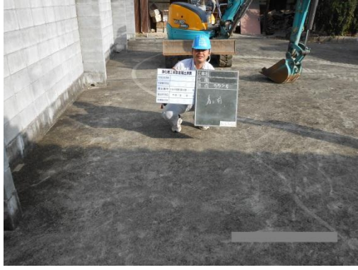
NO.1 浄化槽設置場所 【地縄張り】
