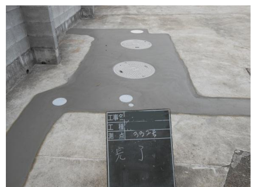
NO.15 完了工事 【コンクリート打設工事】
