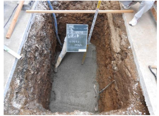
NO.6 基礎工事 (100mm 以上) 【基礎底版コンクリート工事】
