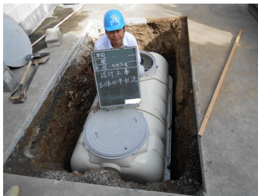
NO.8 据え付け工事 【本体水平状況等】
