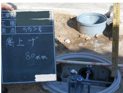
NO.13 特殊工事 【嵩上げ工事】
