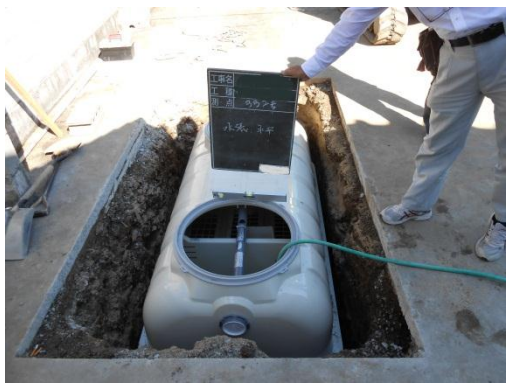
NO.10 埋戻し工事 【水張り状況】
