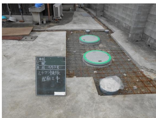
NO.14 上部スラブ工事 【上部スラブ配筋工事】
