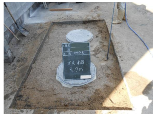
NO.12 埋戻し工事 【上半分 突き固め】
