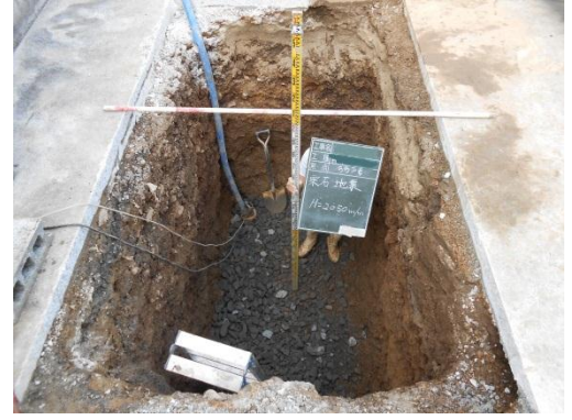
NO.3 基礎工事 (100mm 以上) 【割栗地業工事】
