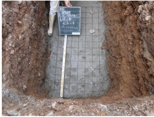
NO.5 基礎工事 (D10-200@) 【配筋・型枠等工事】
