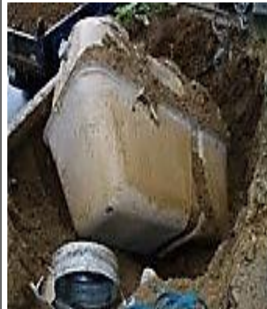
撤去した単独処理浄化槽写真例 (撤去有の場合のみ)
