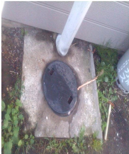
既存の汲み取り便槽写真例
