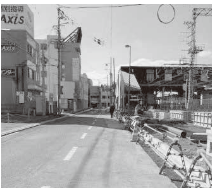
▲尾崎石田線道路の様子
